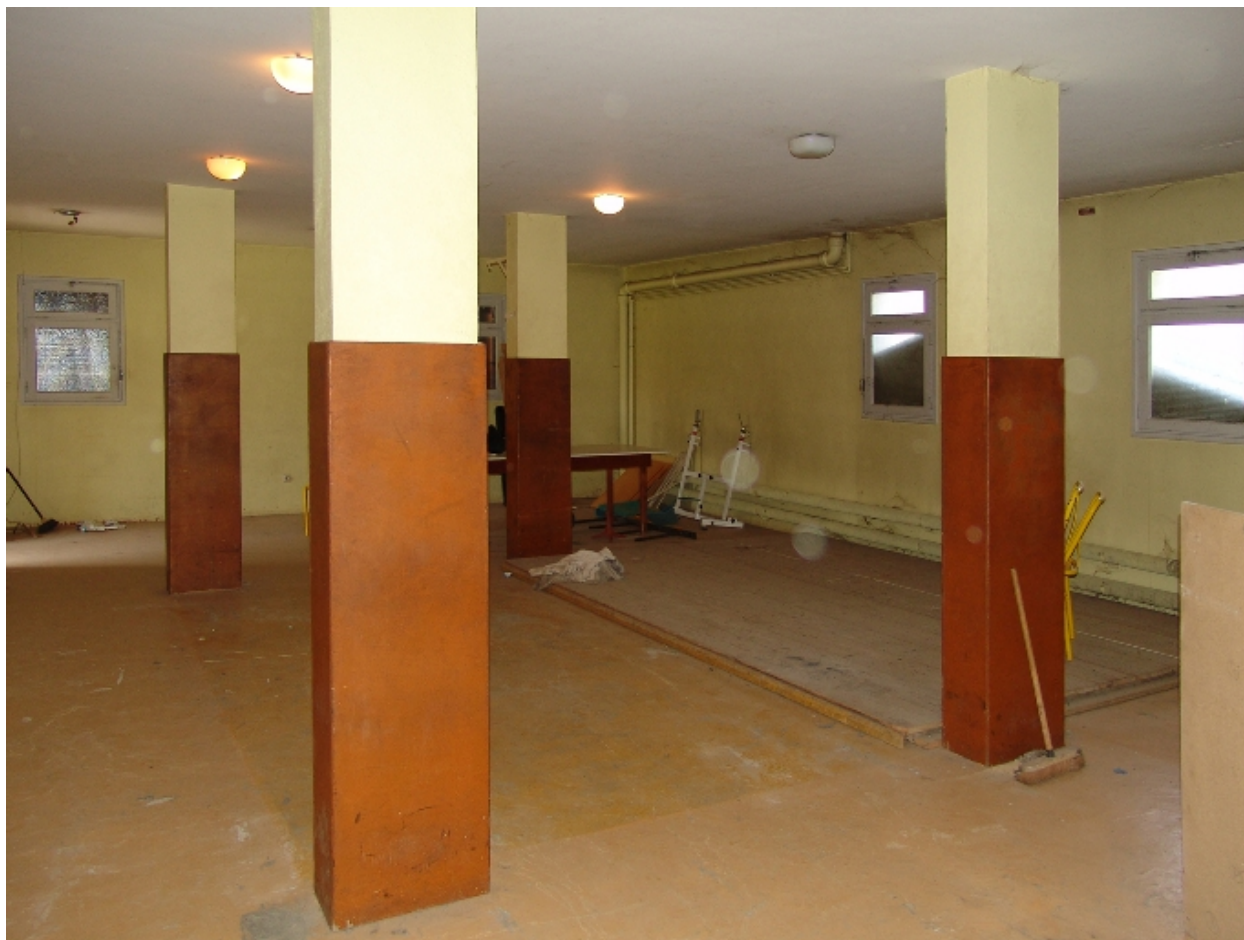
Vue intérieure : partie rénovée
