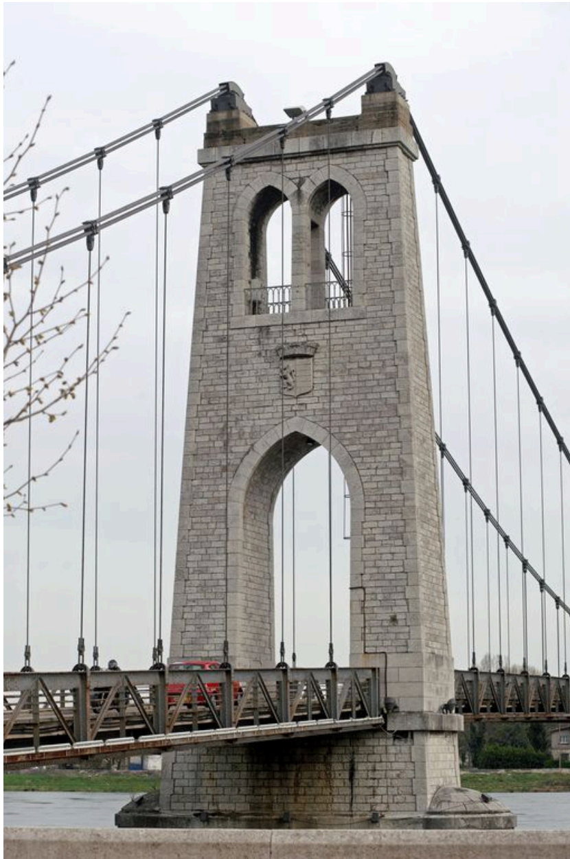
Vue du pylône de droite (côté La Voulte)
