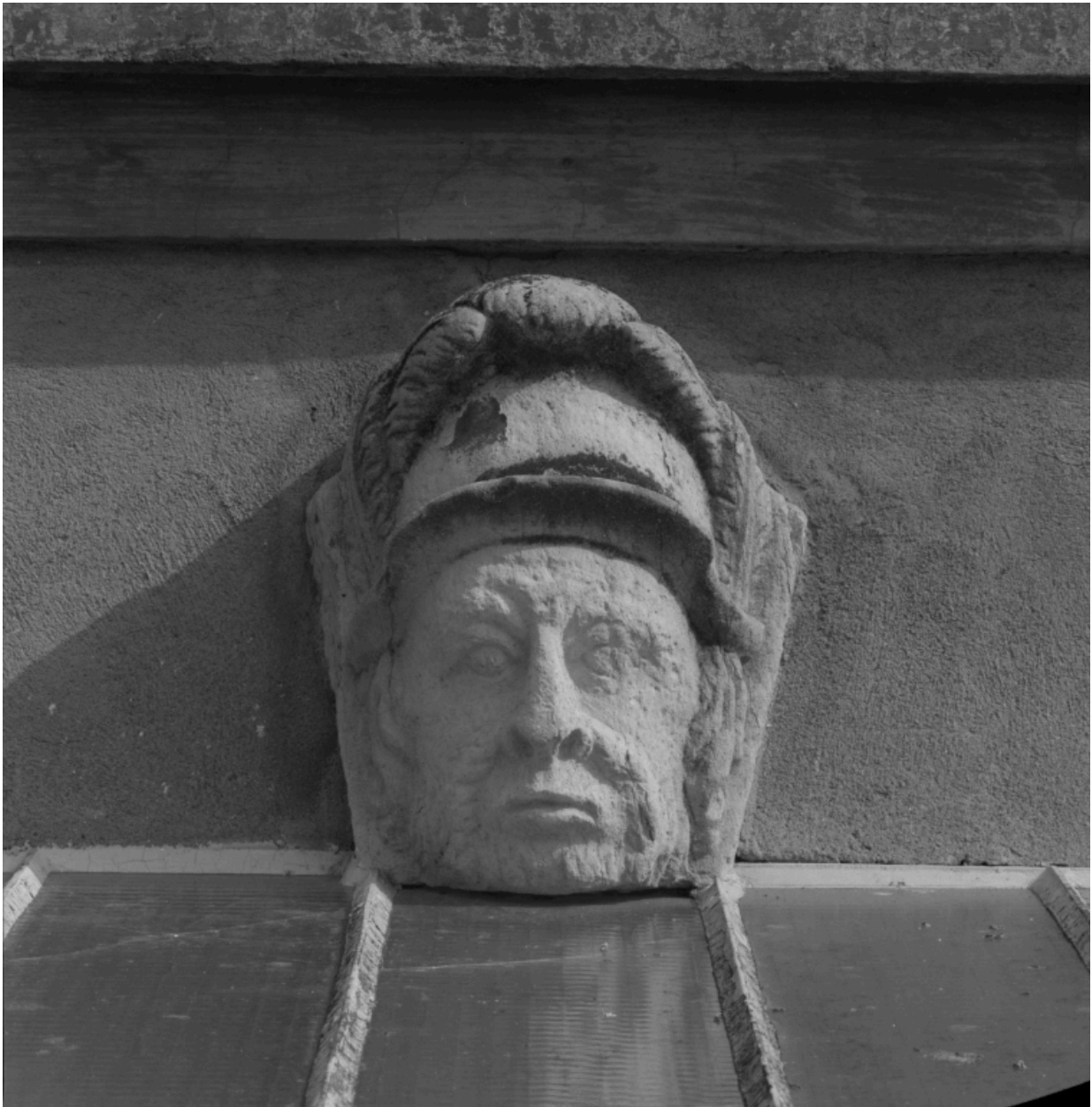
Façade sur jardin, détail : agrafe figurée, baie axiale de l'avant-corps.
