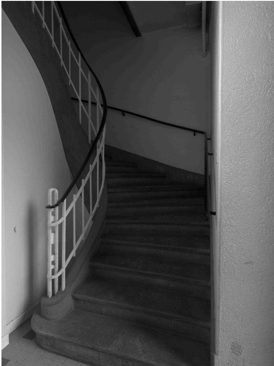
Bâtiment B. Escalier d'accès à un entresol
