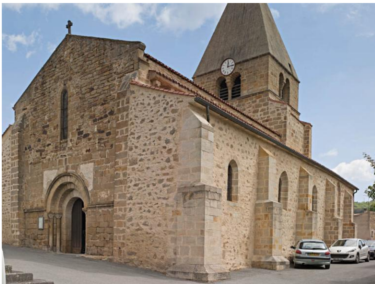
Vue du sud-ouest
