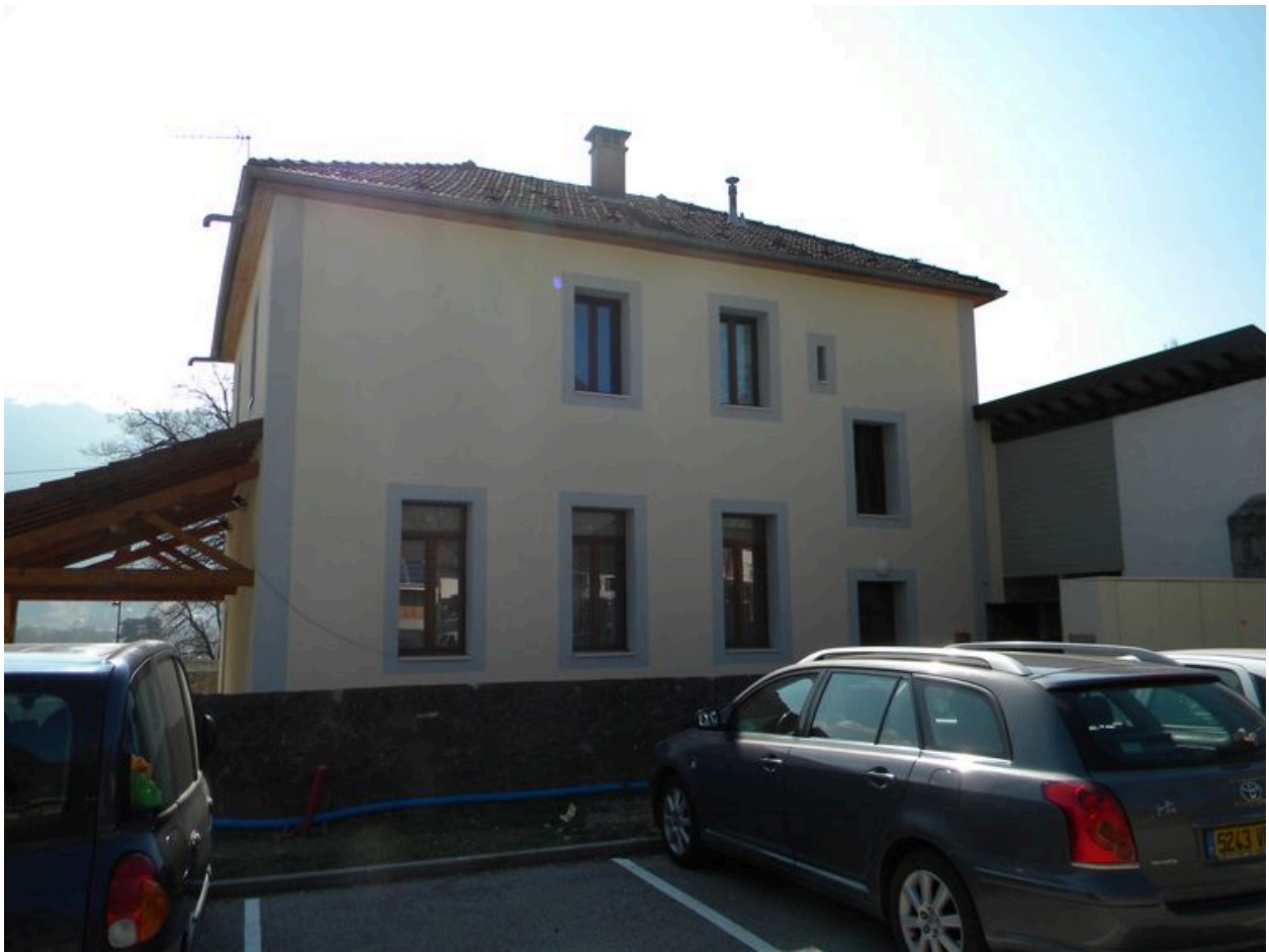
Vue de la façade nord.
