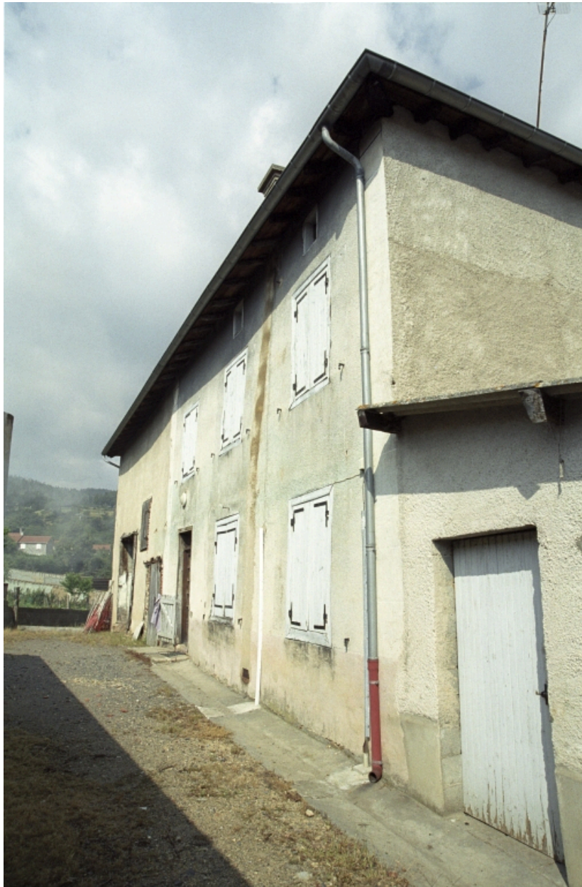
Ferme (A2 700), vue d'ensemble.
