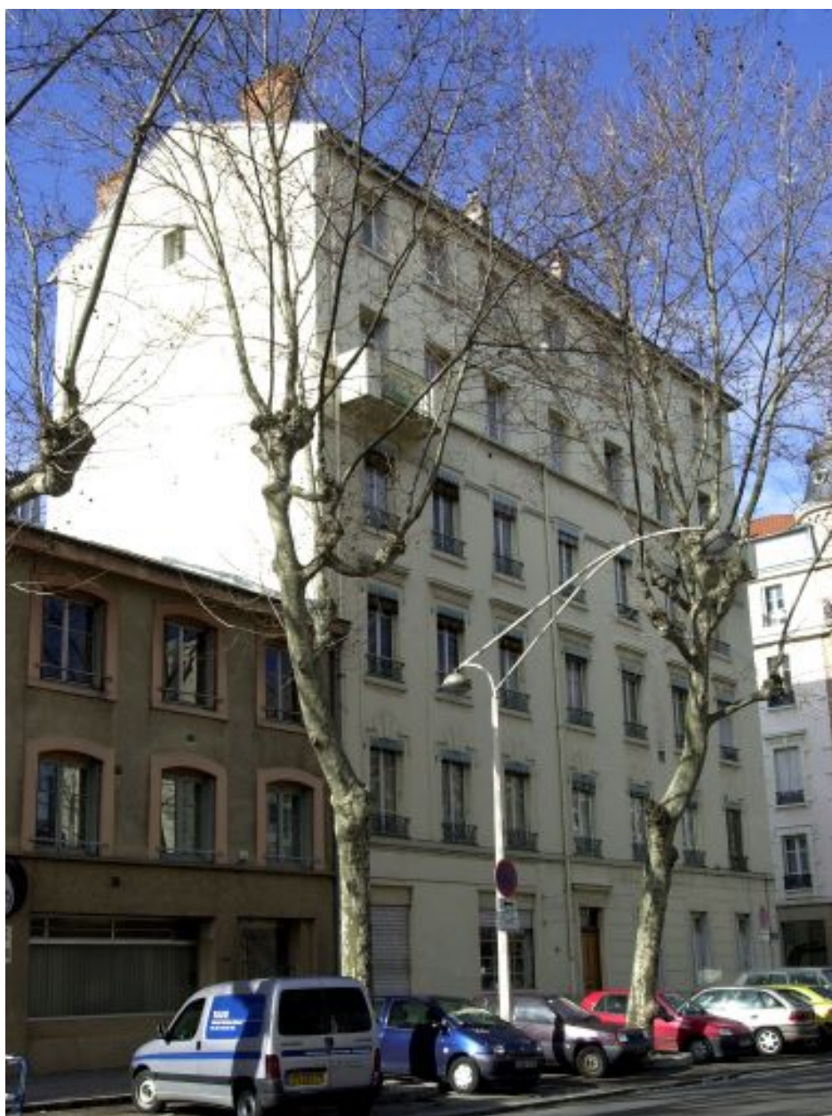
Vue générale cours Suchet, depuis l'est
