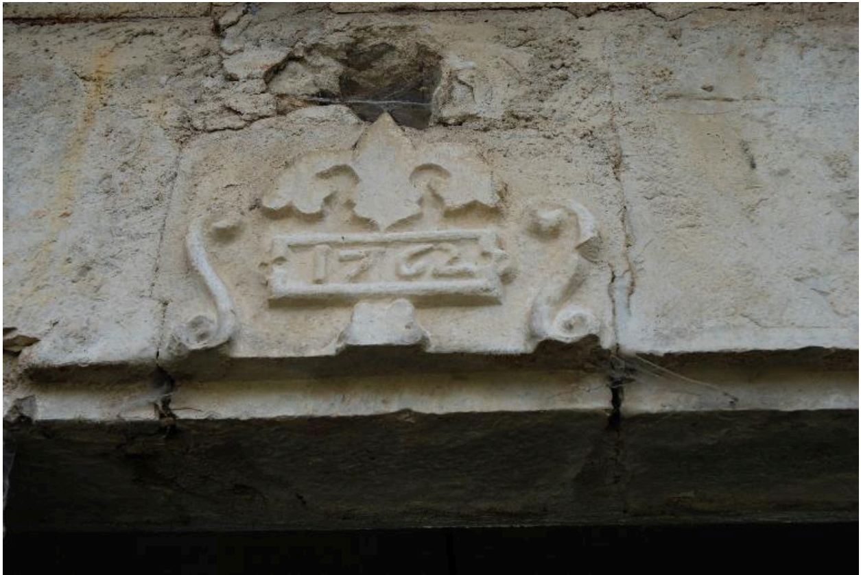
Détail de la grange-étable : cartouche daté 1762.
