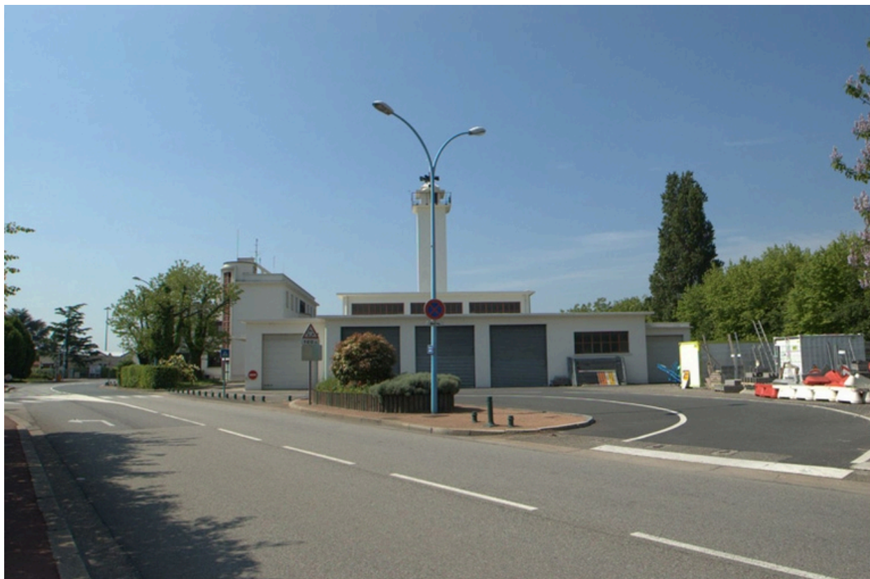
Vue nord du bâtiment administratif
