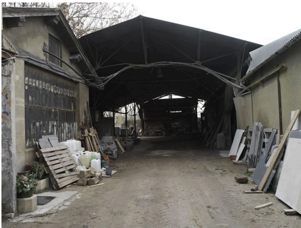
Les ateliers : le hangar (BX 23).
