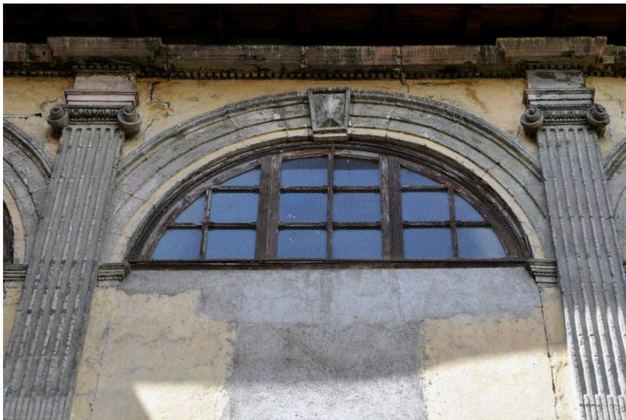
Bâtiment B : galerie, détail d'une baie
