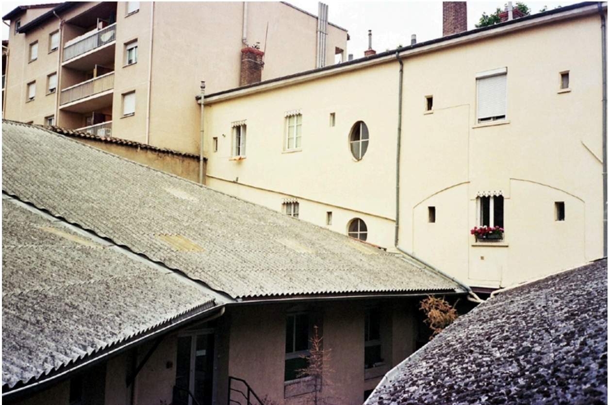
Vue sud-est de l'extension
