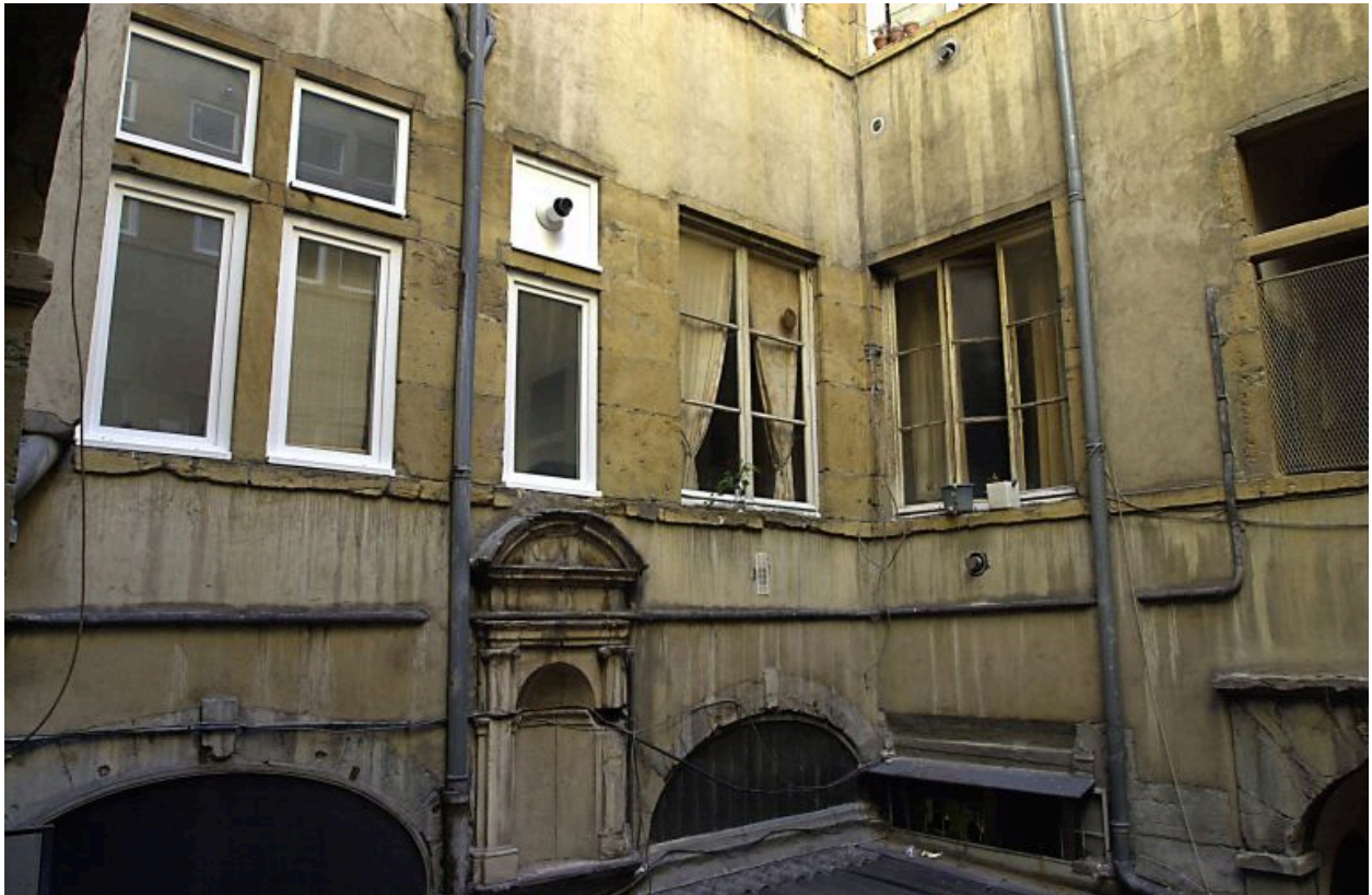
Élévation des deux premiers niveaux du corps à gauche dans la cour
