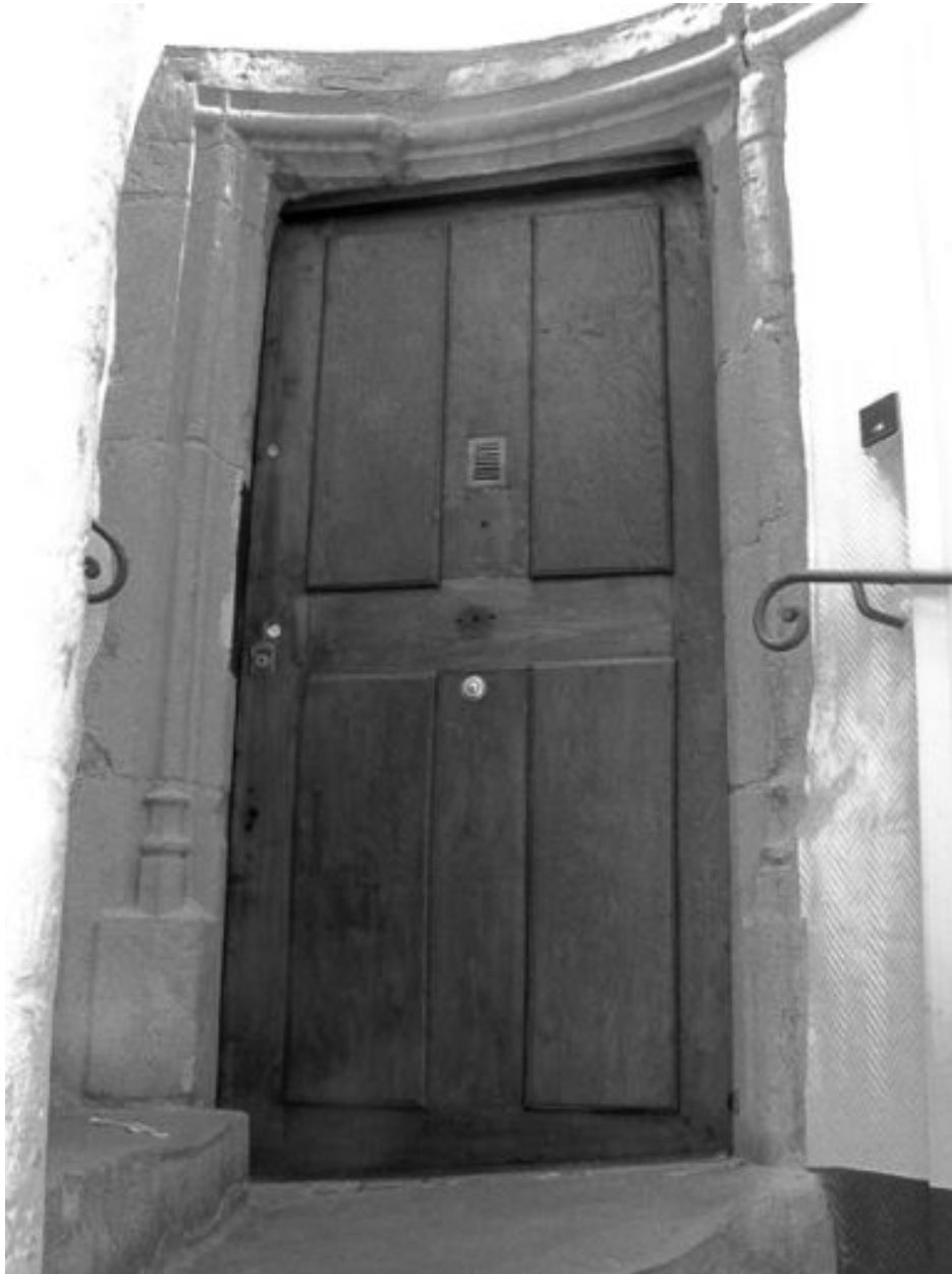
Escalier, porte du 1er étage
