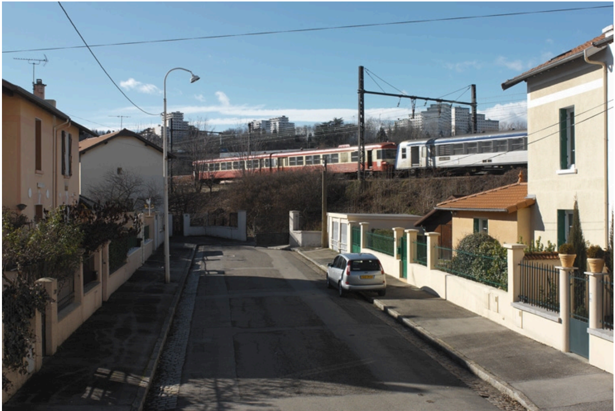
Vue nord-est, fin de l'impasse donnant sur la voie de chemin de fer et accès à la société
