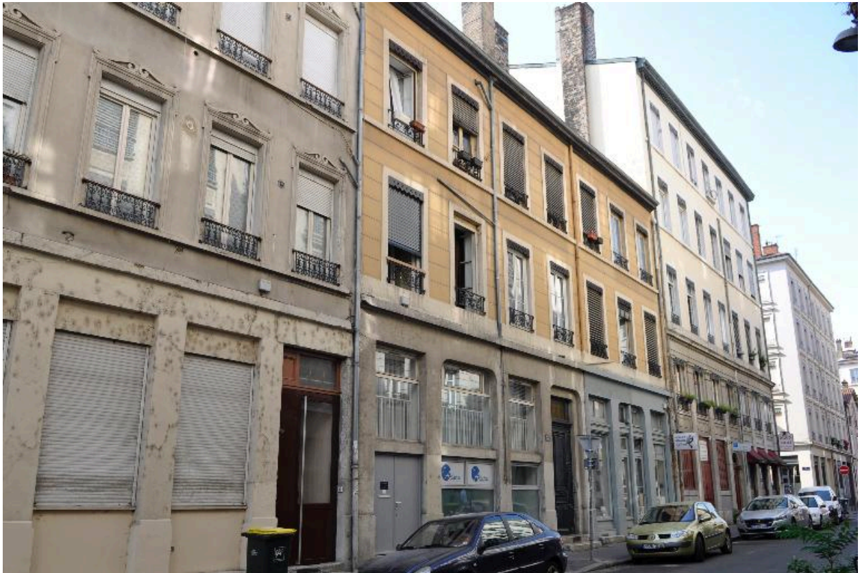
Vue générale de l'élévation sur rue
