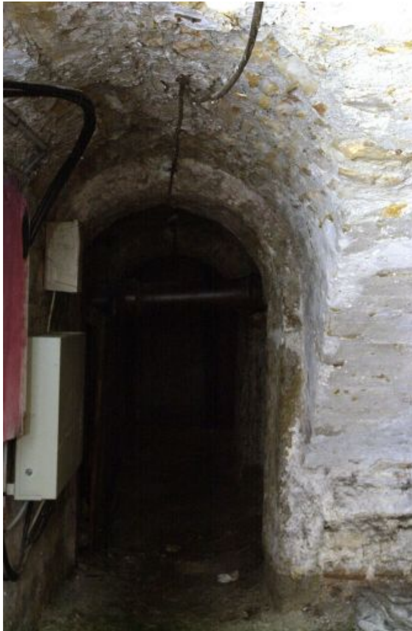
Vue de l'entrée des caves
