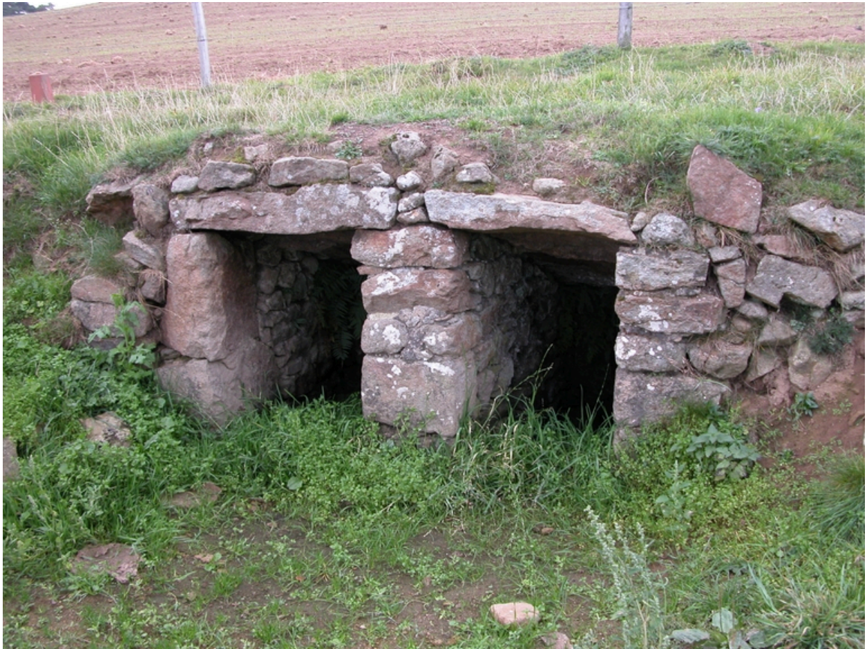
Niches maçonnées (rafraîchissoir à lait ?) en bordure de pré aux Revers (1986 G 334).
