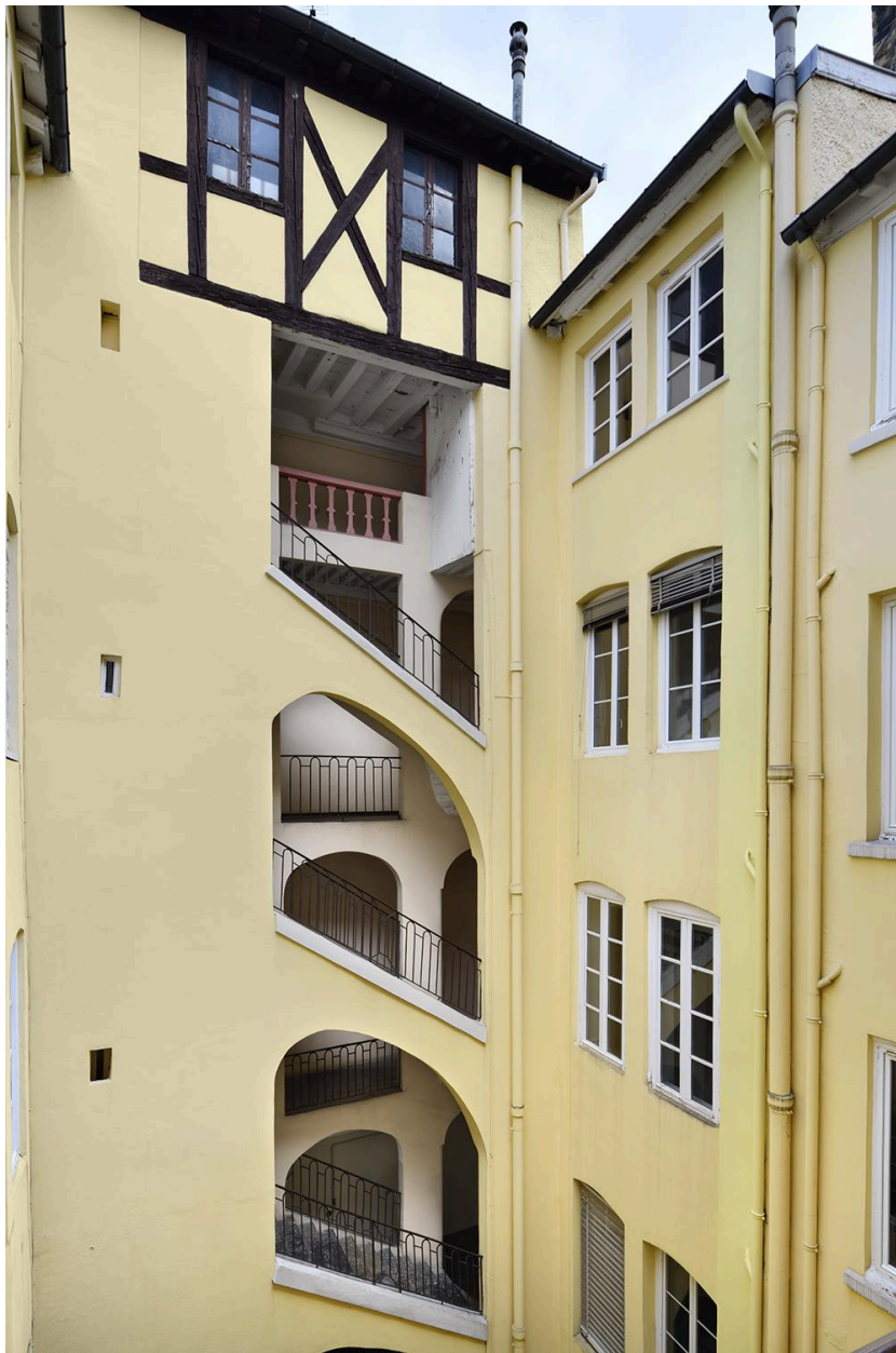
Elévation postérieure et cage d'escalier
