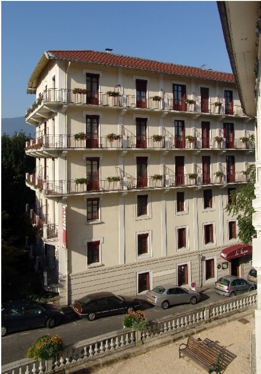
Façade sur la rue Lamartine
