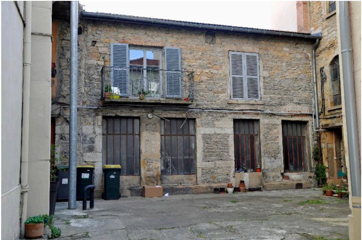
Atelier, vue de l'élévation sur cour en moellons apparents (élévation latérale sud)
