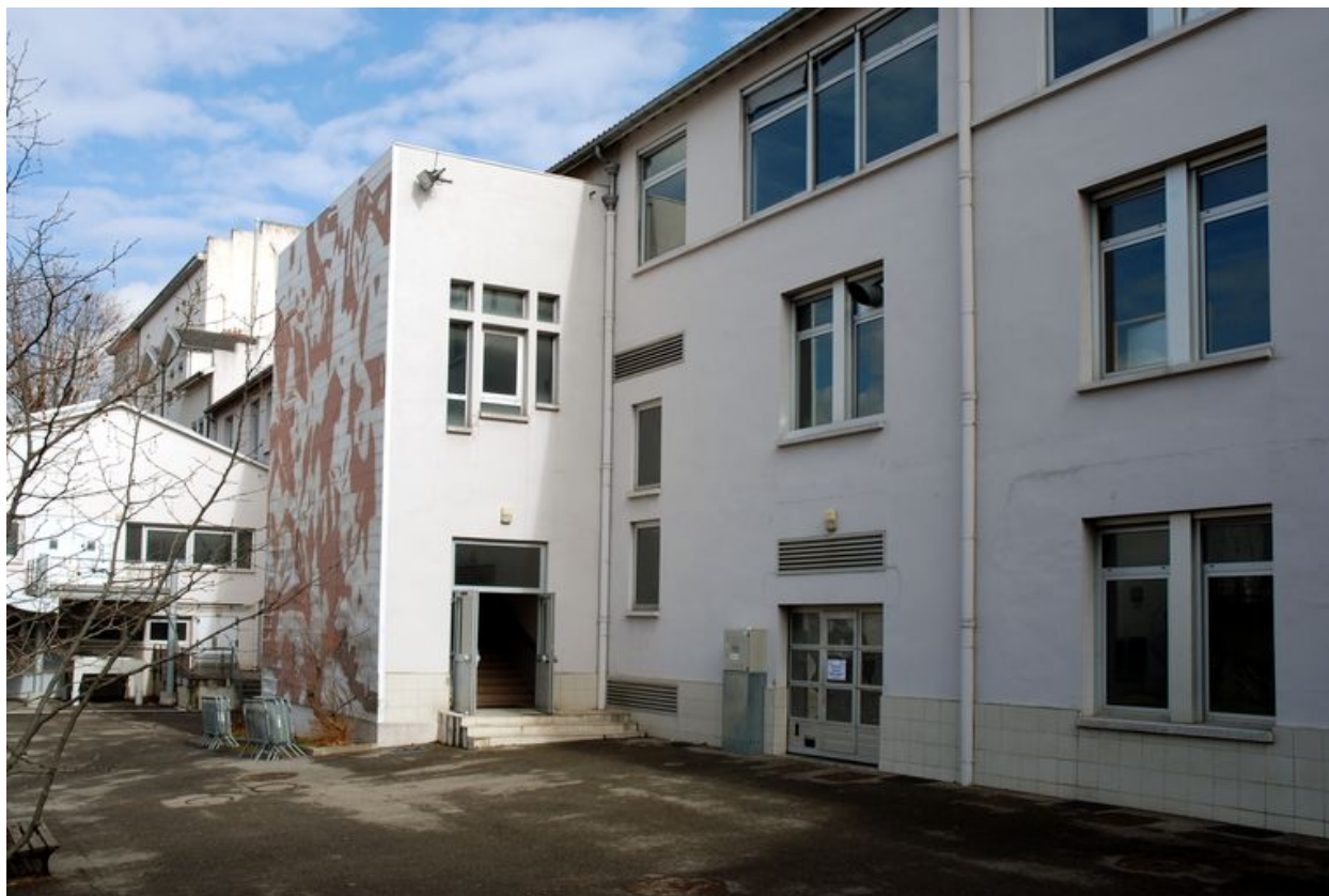
Bâtiment C : cage d'escalier
