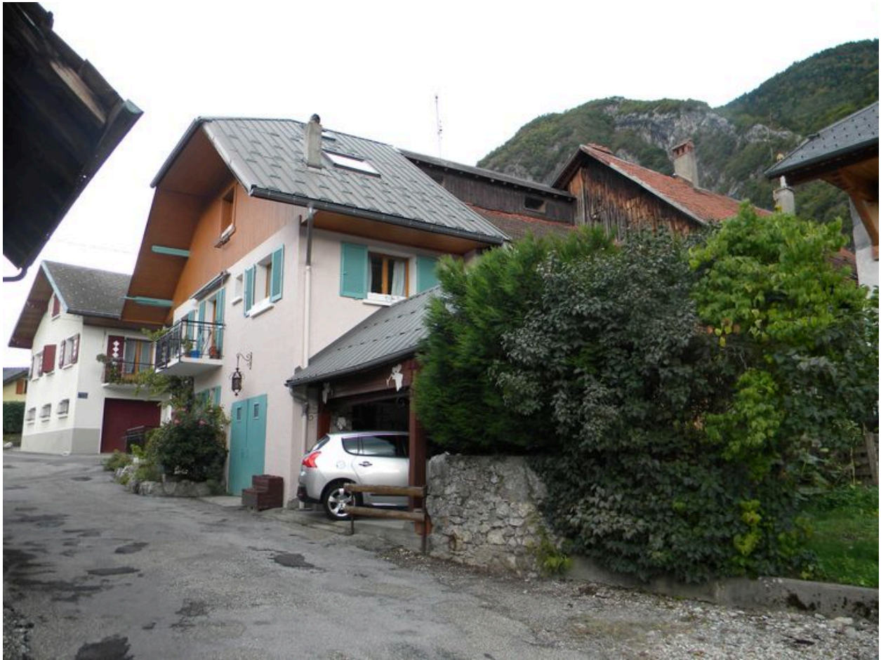
Vue de la partie sud très remaniée d'un ensemble de 5 fermes. (2008 B4 466, 467, 468, 469, 1593, 1734).
