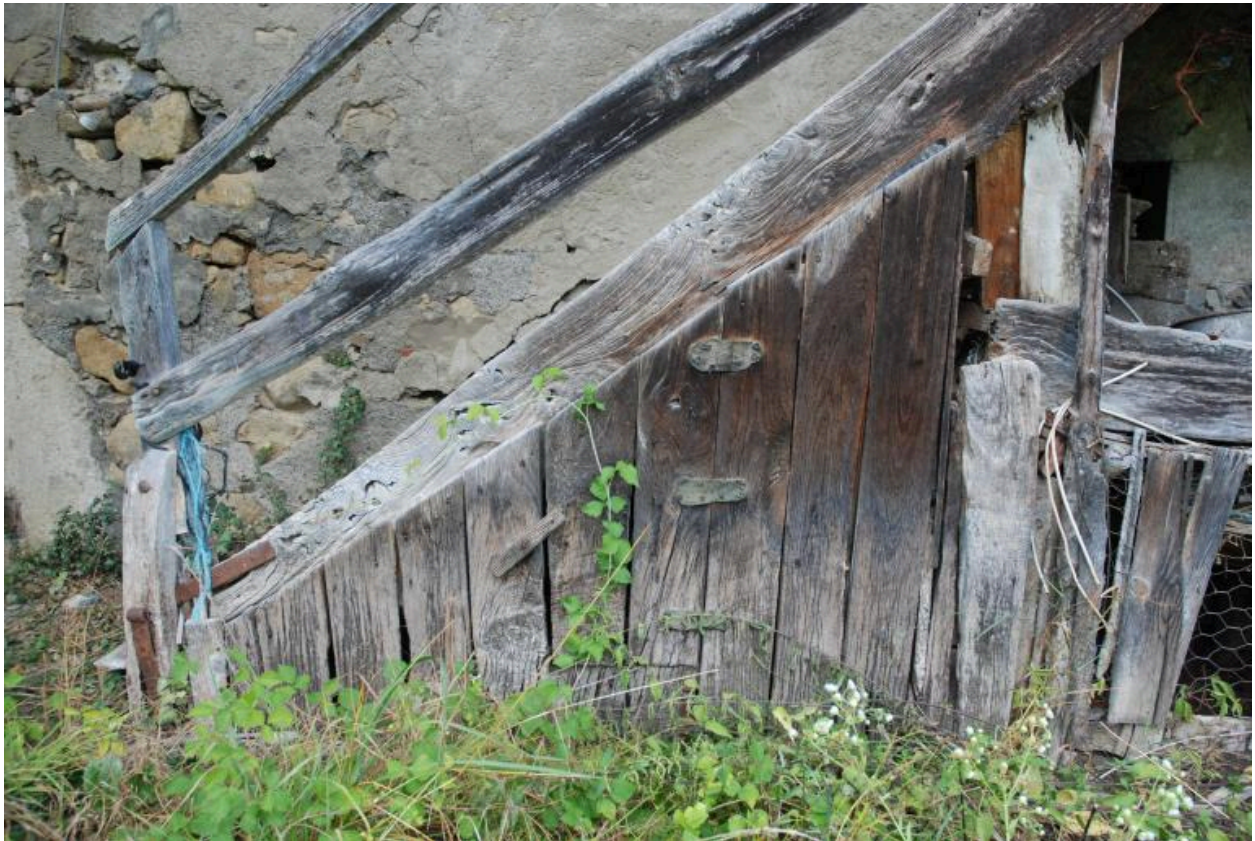
Détail de l'escalier : remise en charpente sous la volée de marches.
