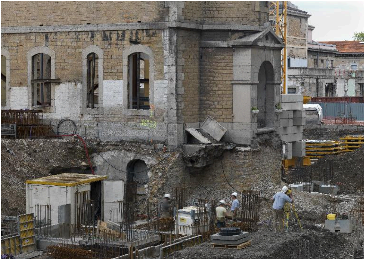
Etat en juin 2013 : les fondations de l'aile sud
