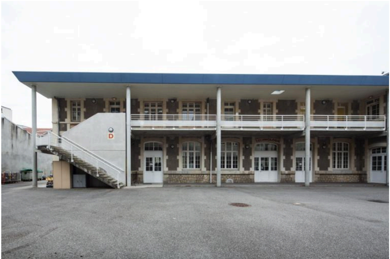
Bâtiment sud : façade nord : aile est.
