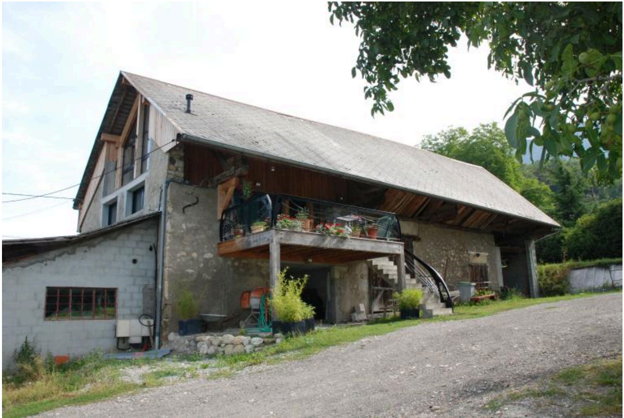
Vue d'ensemble de la façade sud de la grange-étable de la ferme.
