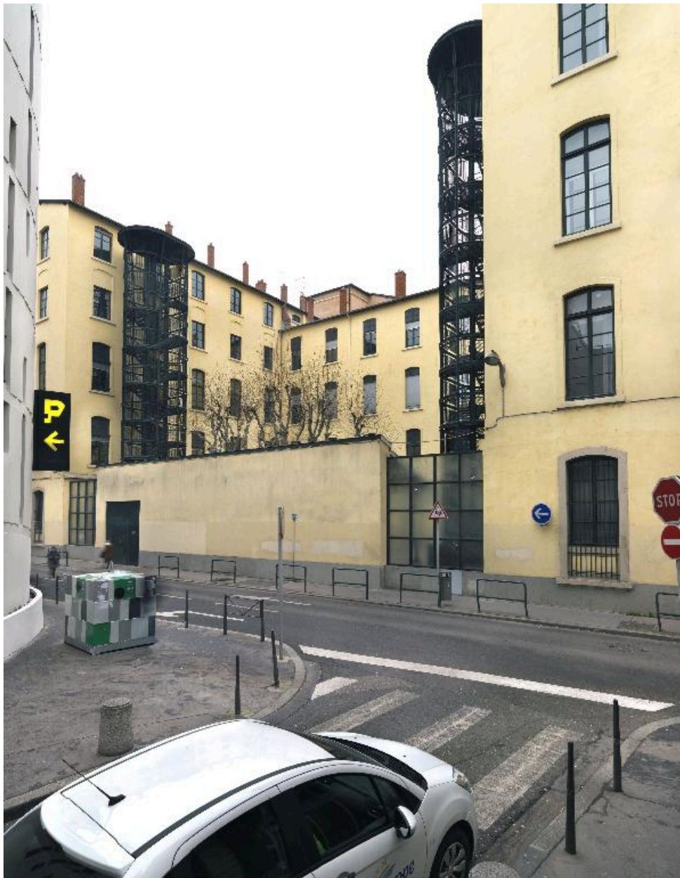
Elévations sur cour, vues depuis le sud-est
