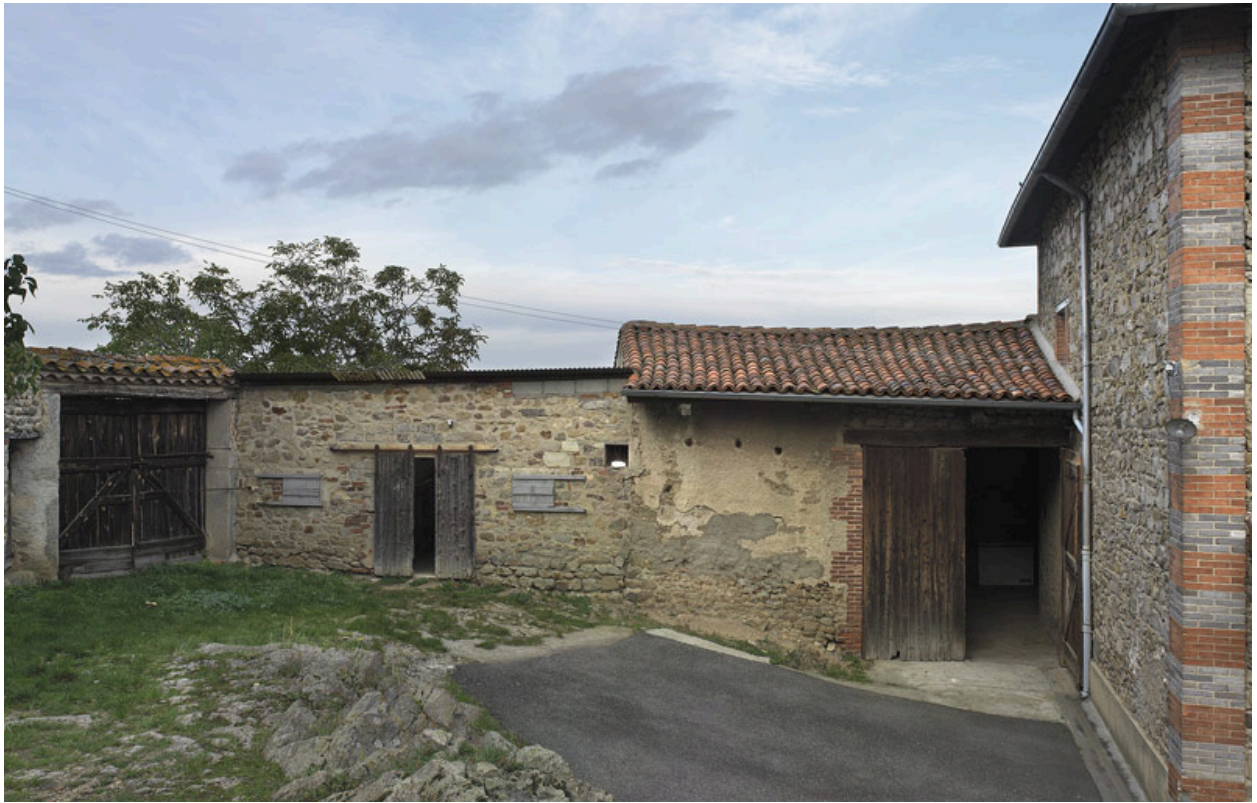
Vue d'ensemble de la grange-étable nord de la ferme, depuis le sud-ouest.
