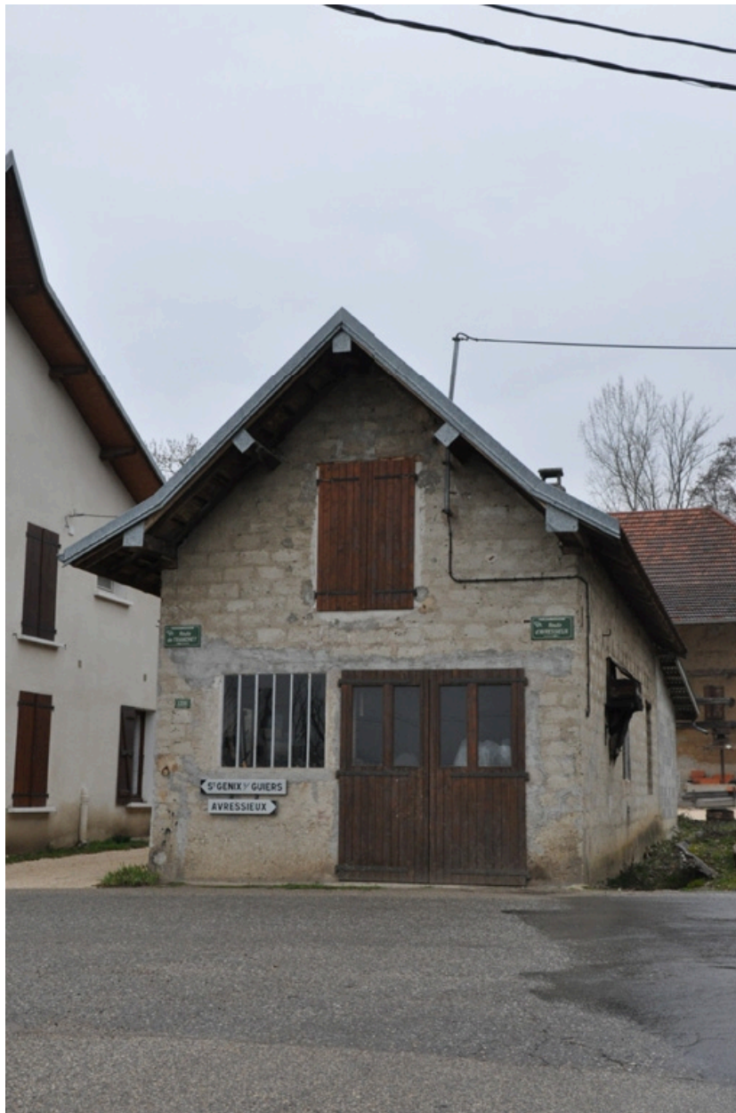
Vue générale de la forge, façade sud-ouest
