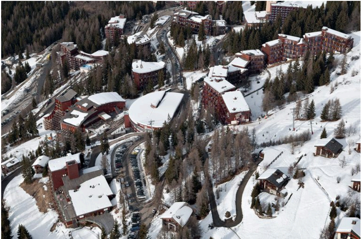
Vue aérienne rapprochée. Charmettoger
