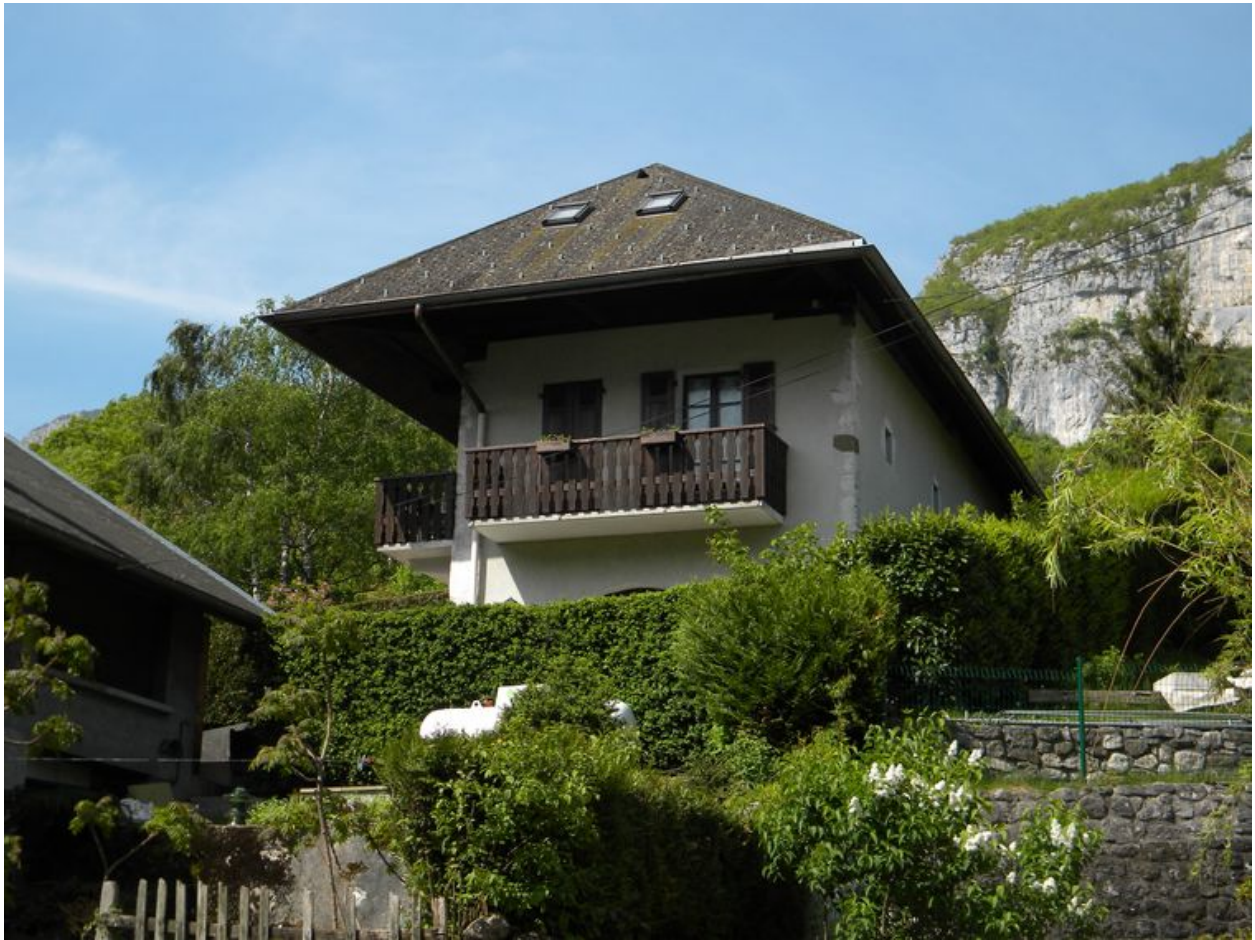
Vue du mur pignon d'une maison d'habitation (2008 A3 284)
