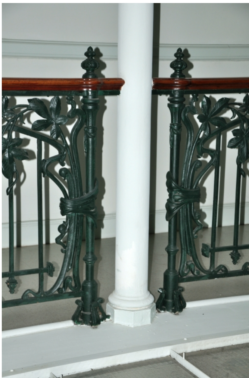
Corps principal : garde-corps de l'atrium, détail
