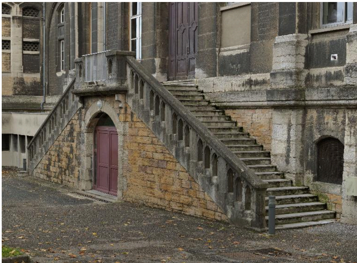
Elévation latérale nord-est, détail de l'escalier
