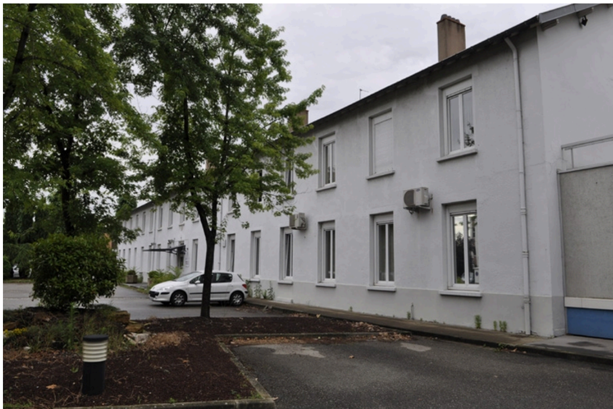
Bâtiment de 1913, façade est.
