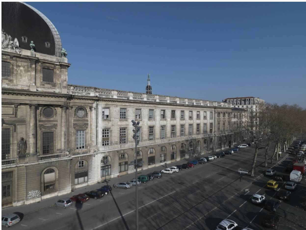
Bâtiment K. Vue d'ensemble de la façade sur le quai depuis le sud-est
