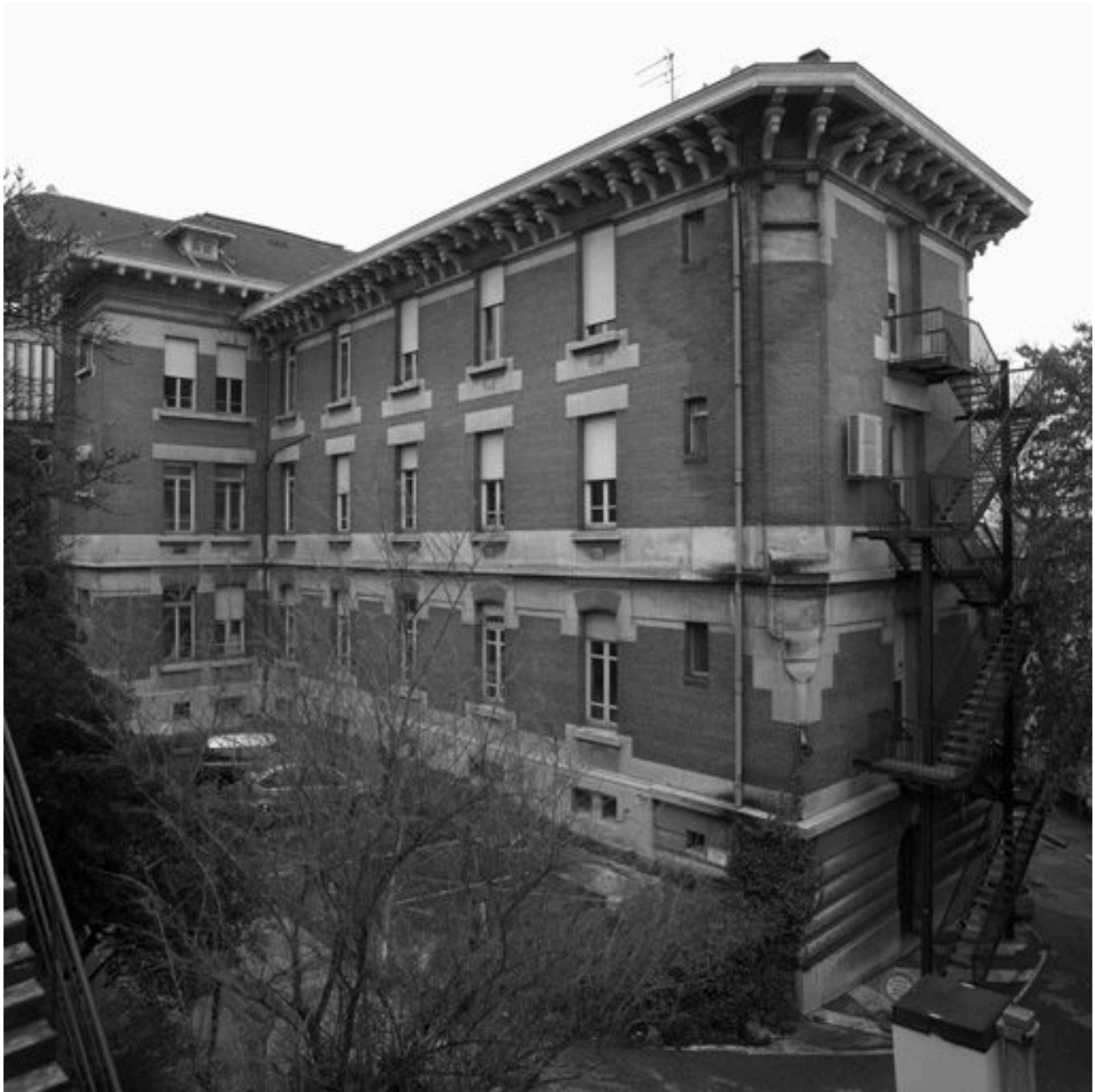
Bâtiment B, façade ouest, partie sud
