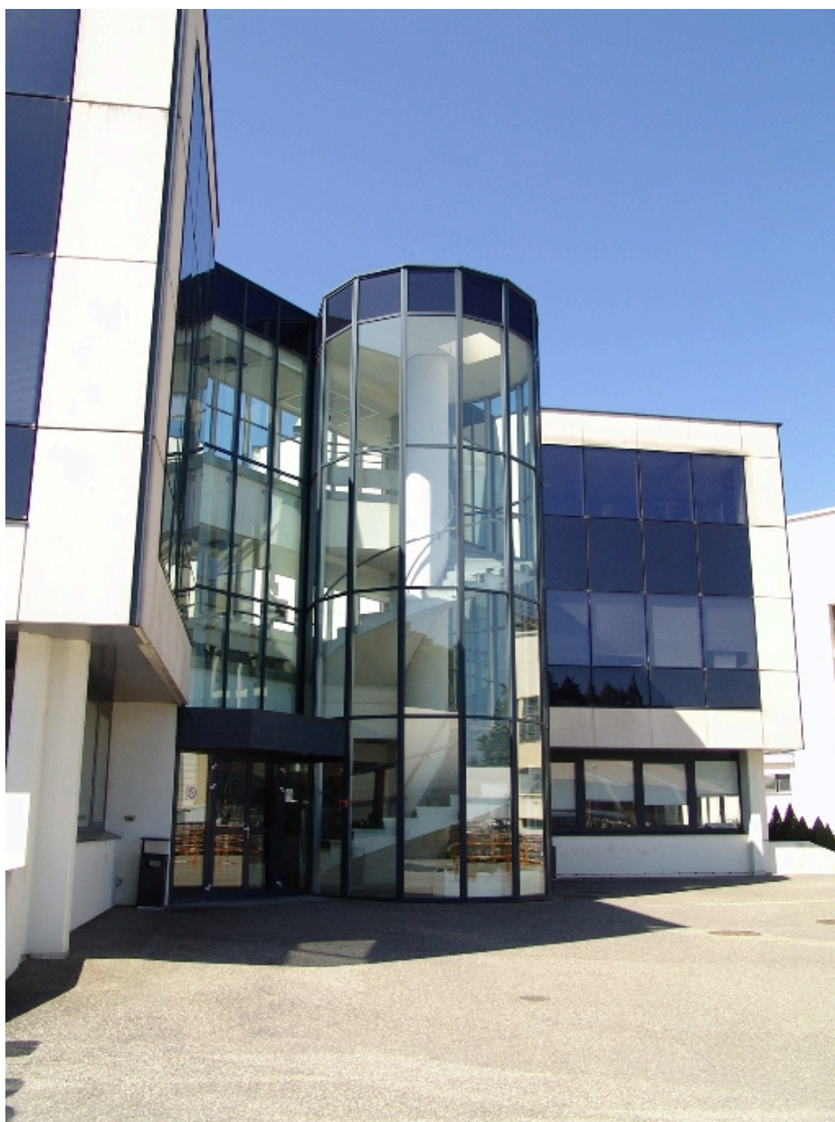
Entrée et escalier en vis
