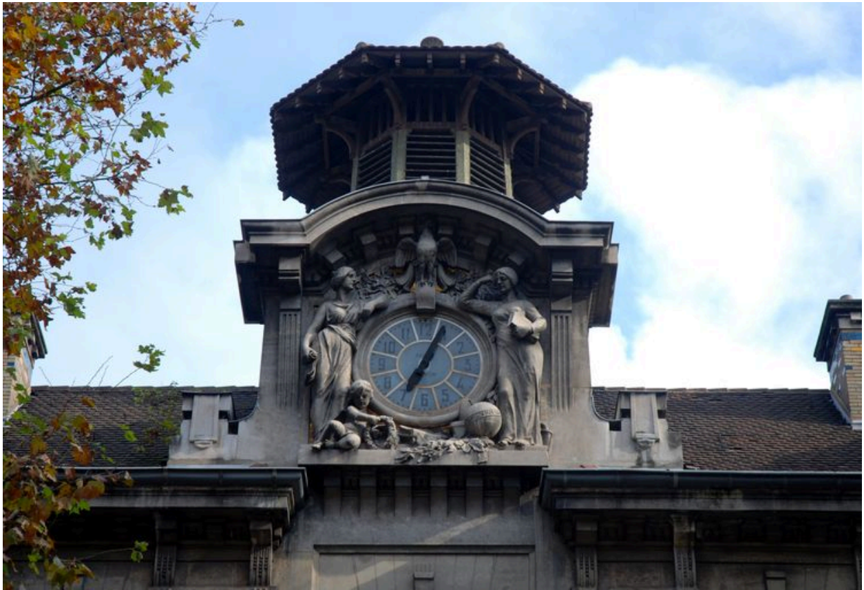
Eélévation principale, horloge
