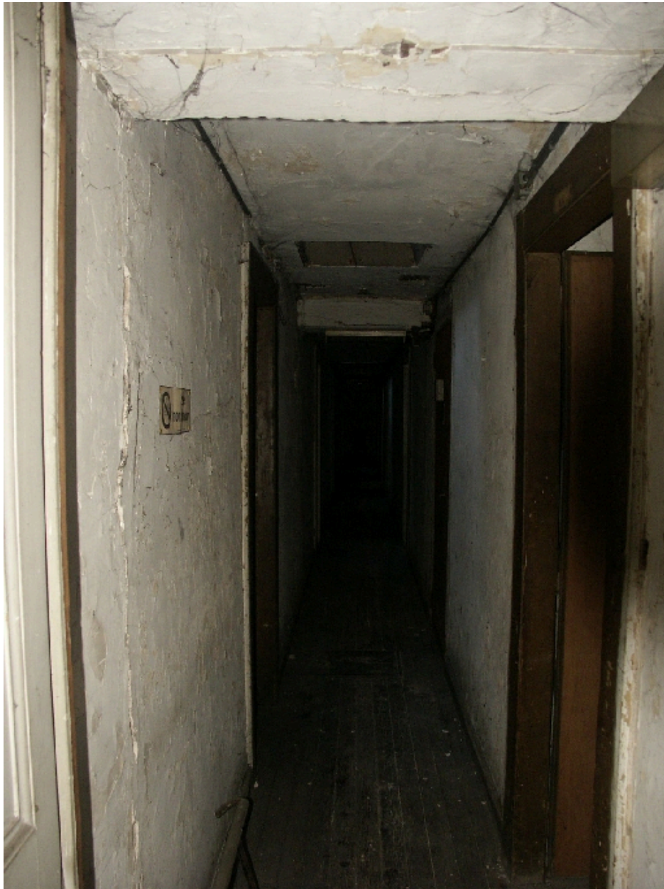
Couloir de l'étage de comble
