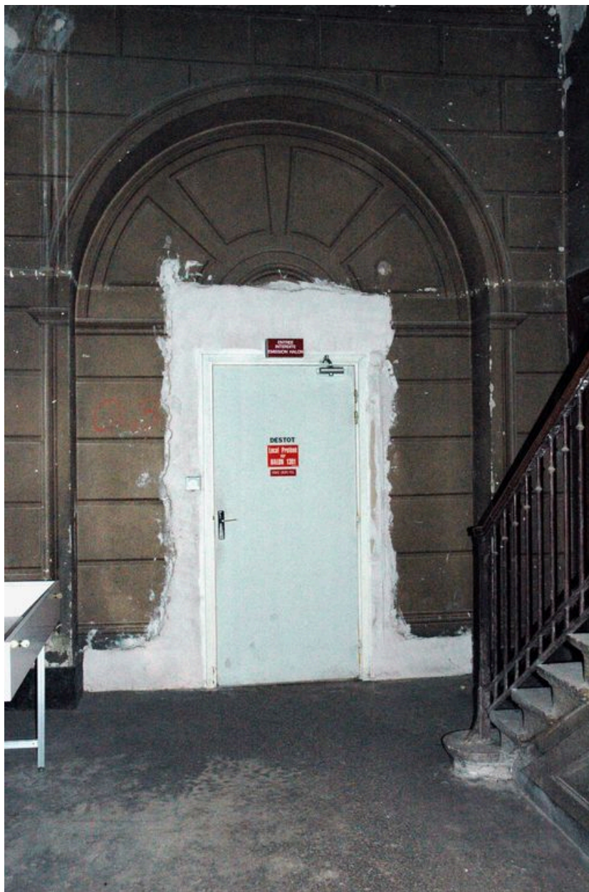
Cage de l'escalier ouest, porte d'accès au parloir (dénaturée)
