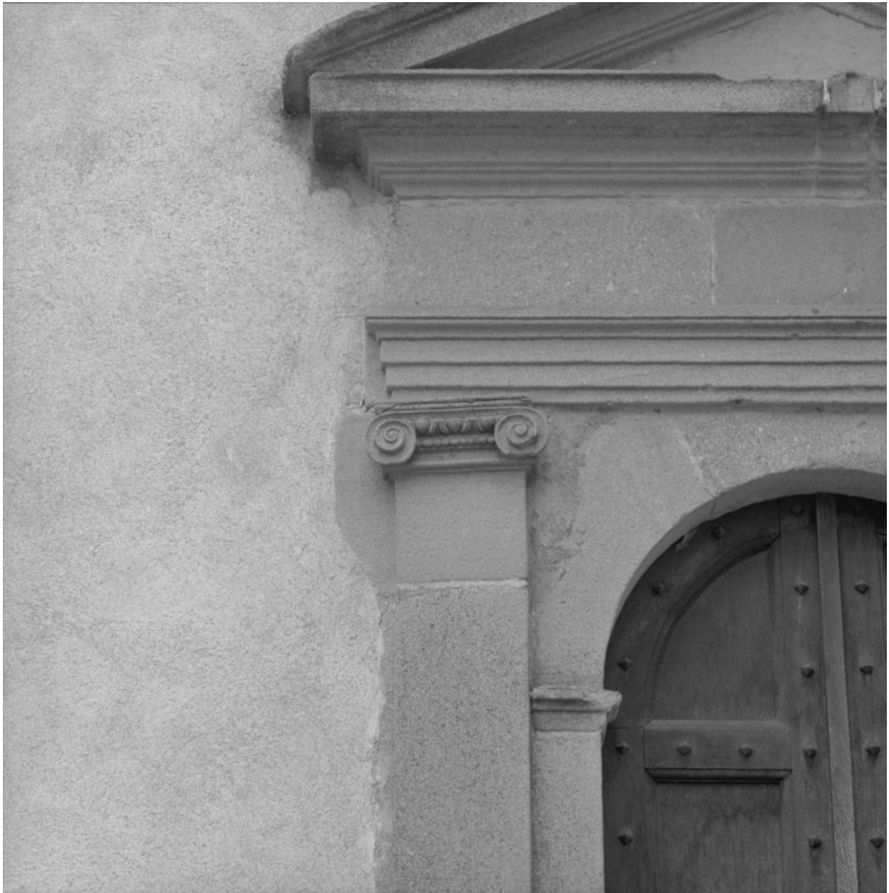
Corps dit "de garde" : chapiteau d'une des portes ouvrant sur la cour.
