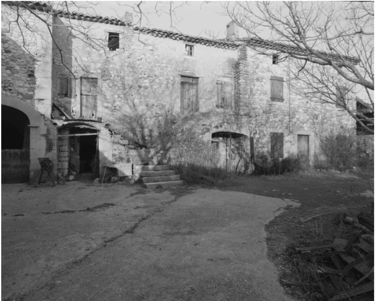
Les Combes (ZB 208). Ferme, élévation principale.
