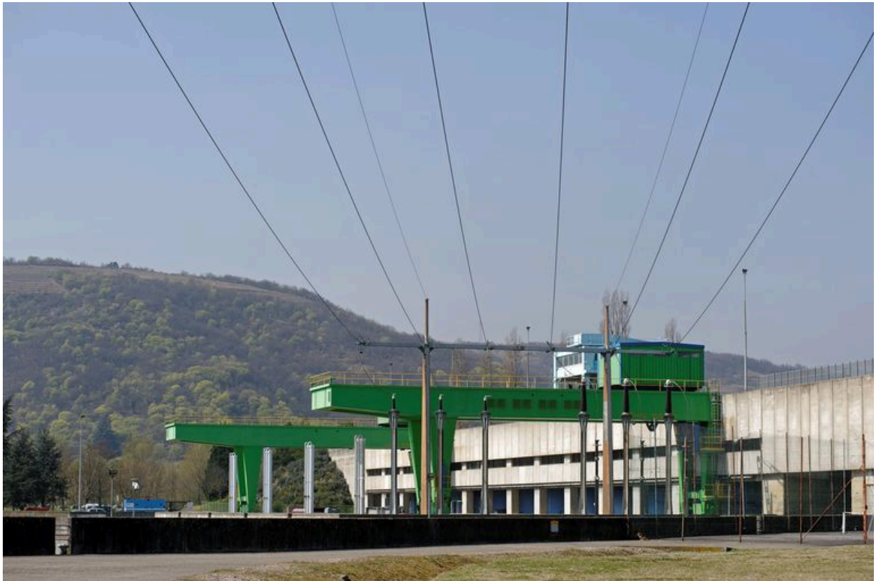
Centrale hydroélectrique, vue partielle, côté aval (depuis la rive gauche)
