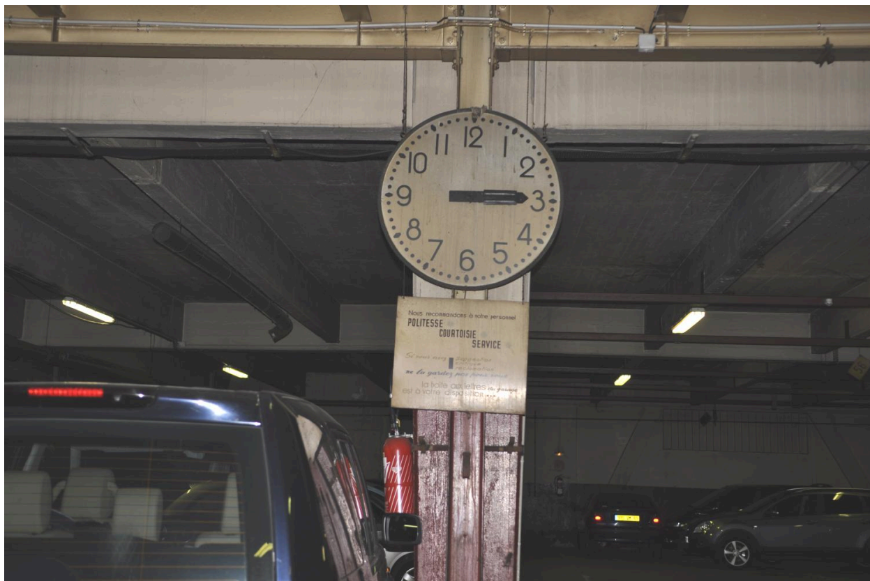
Détail de l'horloge présente dans le parking souterrain
