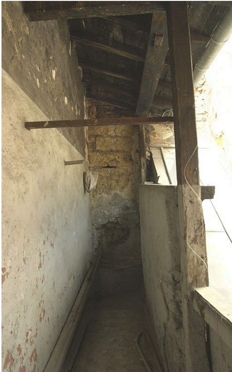
Galerie desservant le corps de bâtiment ouest et pourvue de WC au fond
