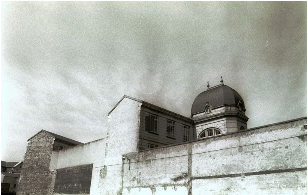
Façade postérieure et murs mitoyens, 1988
