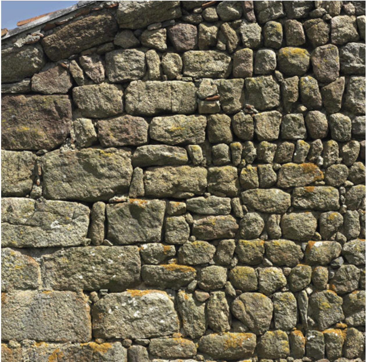
Mur pignon de la grange-étable : détail de l'appareillage à petit moellon sur chant.
