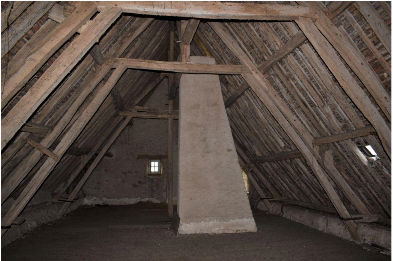
Vue de la charpente du grenier de l'ancien logis avec le conduit de la cheminée centrale.
